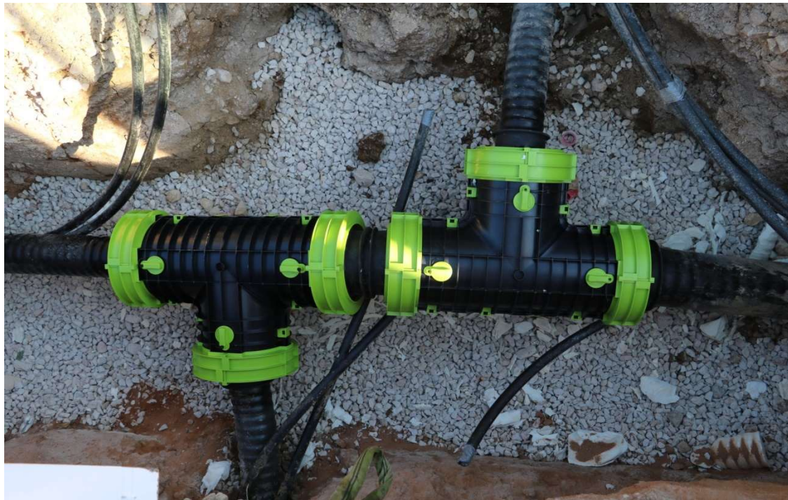
T-Stück im offenen Graben
